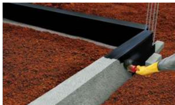
Figura 7: Aplicação deverá ser feita; - Sobre viga, laterais internas e externas, preferencialmente com recobrimento total da viga em uma demão, e após termino de secagem reaplicar em pontos que eventualmente se mostrem não cobertos.
